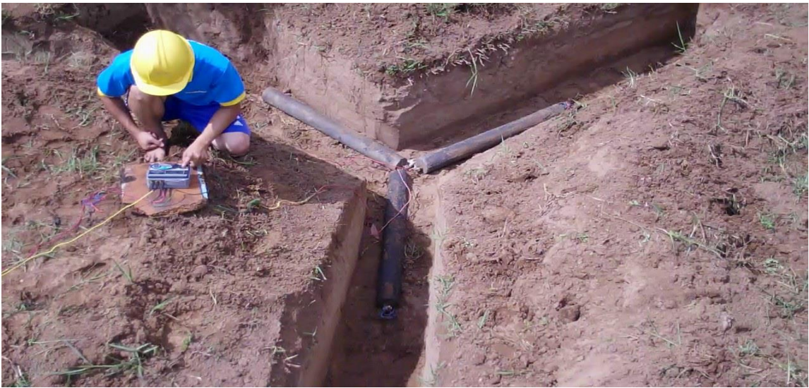
Hình 2.13: Hệ thống nối đất hình tia n = 3 , L_T = 1 m, C = 0,05 m
