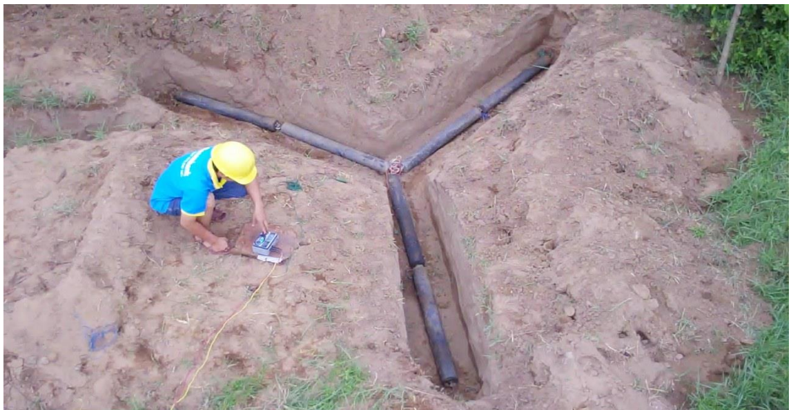
Hình 2.14: Hệ thống nối đất hình tia n = 3 L_T = 2 m, C = 0,05 m
