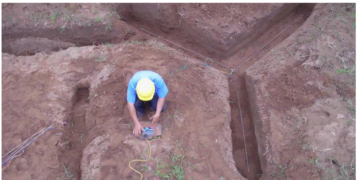
Hình 2.12: Hệ thống nối đất hình tia N = 3 , L_T = 2\text{m} , d = 0,01\text{m}
