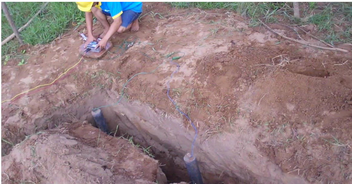
Hình 2.4: Hai cọc, a = 1\text{m} , L_C = 2\text{m} , C = 0.05\text{m}
